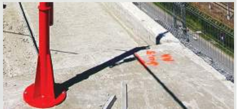
Gniazdo kotwione do stropu.
