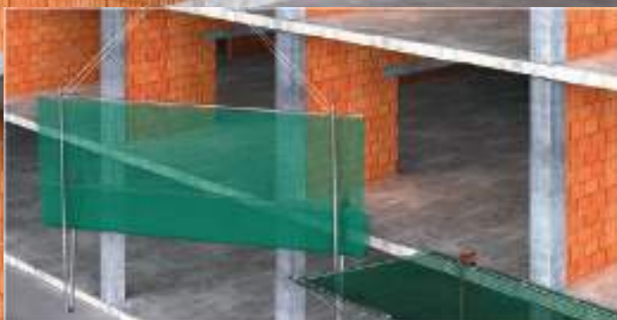
System modułowy mocowany od góry.
