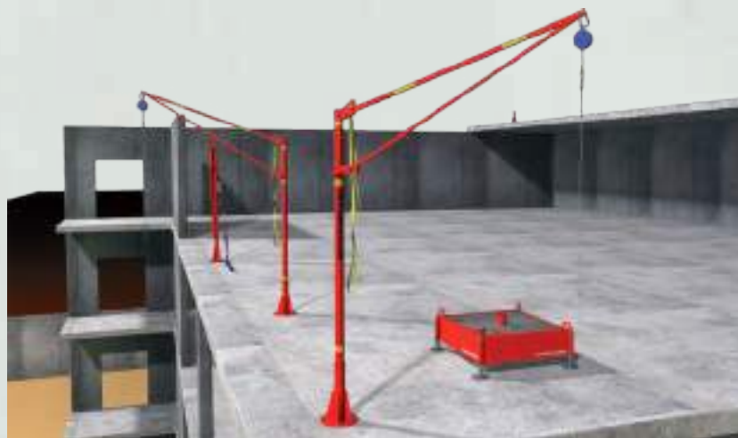
Szubienica ze stopą kotwioną do podłoża.
